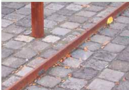
Belægning kantet med stålkant
