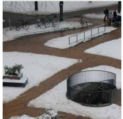
Snerydning med køretøj på kælderdek stiller særlige krav til dimensionering af dækket
