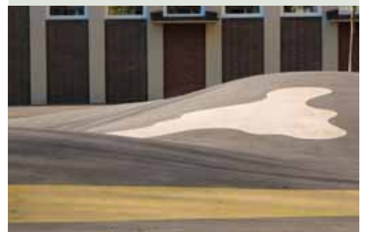
Asfalt anvendt som belægning på bølget legeareal
